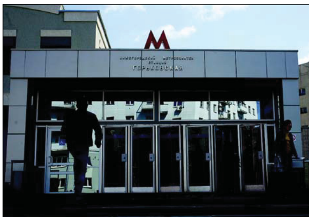
Станция метро «Горьковская»
