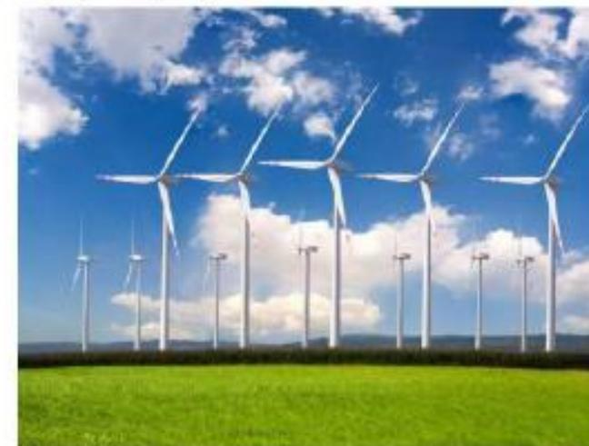
Практически все ветрогенераторы имеют общий принцип работы. Под действием воздушного потока лопасти приходят в движение и вызывают вращение ротора генератора. Сам ротор помещён внутри статорной обмотки, и в результате его вращения вырабатывается электрический ток. Полученное электричество накапливается в аккумуляторной батарее.
